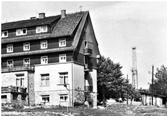
Průzkumný vrt nad zotavovnou Dolu Rudý říjen
