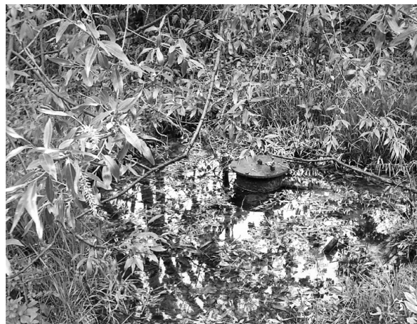
Zaplombovaný vrt jodobromové vody
