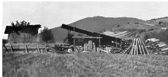
Ukázka jednoduché cihelny, vlevo tzv. „kozol“, uprostřed přístřešek pro sušení cihel
