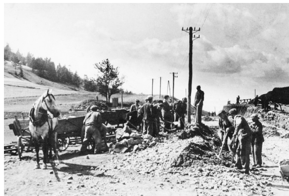
Stavba silnice na Pinduli koncem 30. let minulého století
