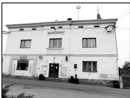
Budova obecního úřadu v Poličné.
