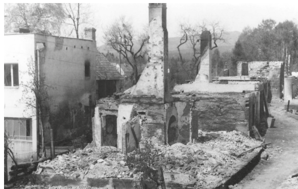
Spáleniště domu čp. 120, květen 1945
