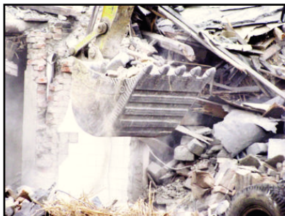
Demolice Jakšíkovy usedlosti v prosinci 2008.
