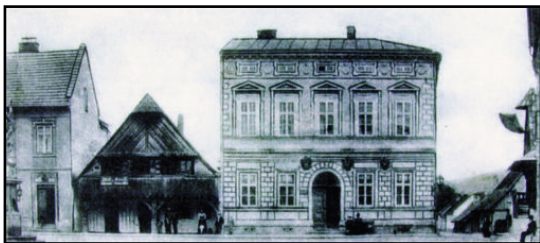
V budově městského úřadu měla sídlo celá tehdejší administrativa.
