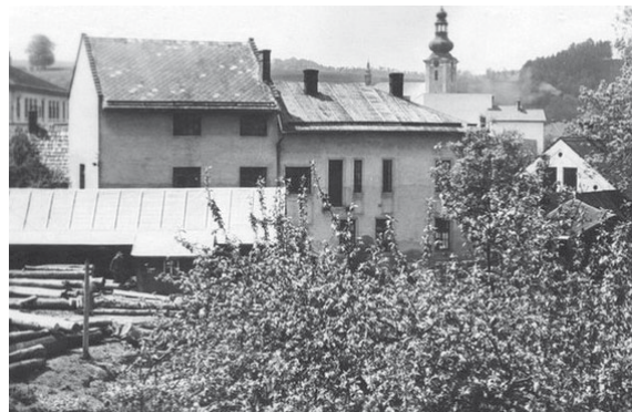
Pohled na Palačkův mlýn a pilu (1935)
