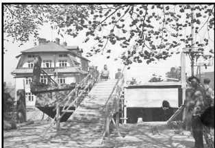
Zničený dolní most ustupující německou armádou v neděli v noci 6. května 1945. Na pozadí vlevo je Nývltova vila.
