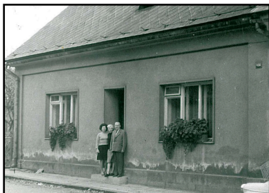
Promáčené zdi domu č. 458 v důsledku rozlití struhy.
