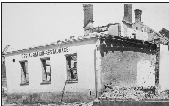
Hostýnek - zájezdní restaurace v Horní ulici byla při přechodu fronty poškozena do té míry, že už nebyla nikdy obnovena.
