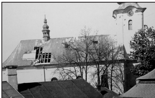
Místní kostel byl poškozený do té míry, že rozloučení s padlými se muselo odbýt na náměstí.
