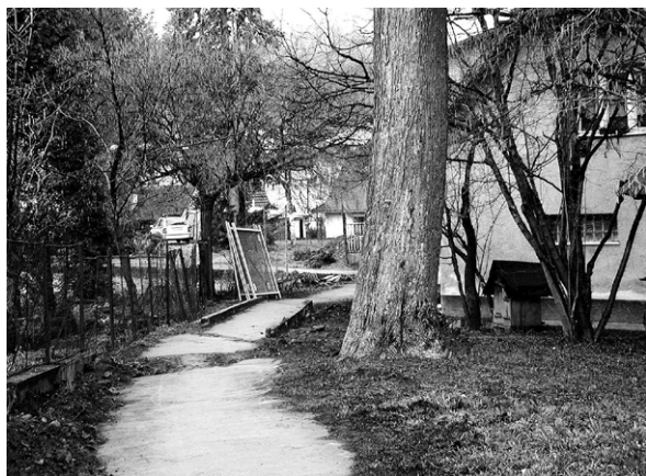
U Jakšíkovy usedlosti zbyl betonový můstek, který původně překlenoval Struhu. S výstavbou nové budovy Charity také zanikl.
