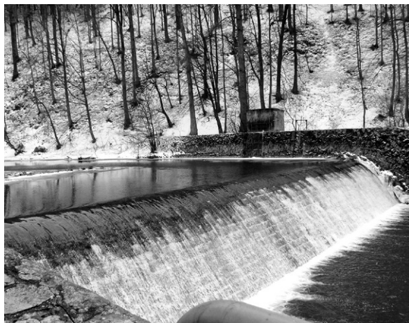
Horní rožnovský splav. Dřevěná stavba na protějším břehu je vpust vody z řeky Bečvy do Struhy.
