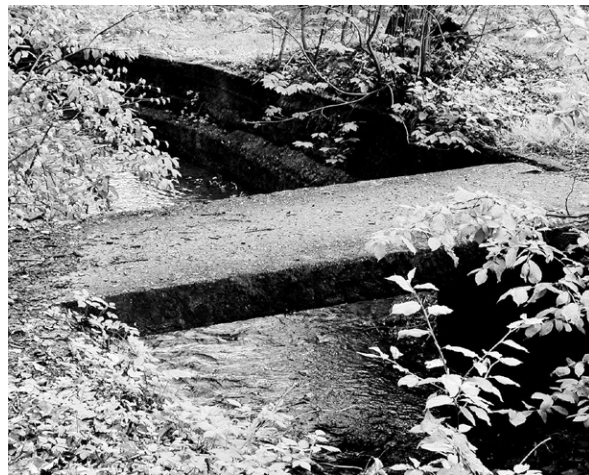
Pod Karlovou strání překlenuje Struhu betonový můstek.
